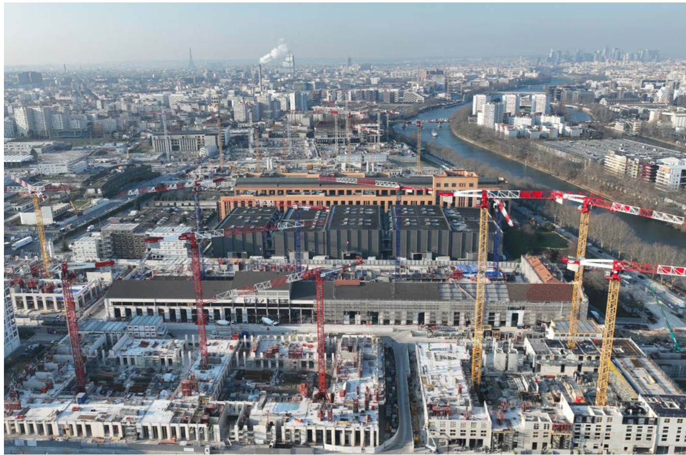
Le Village en chantier, mars 2022
