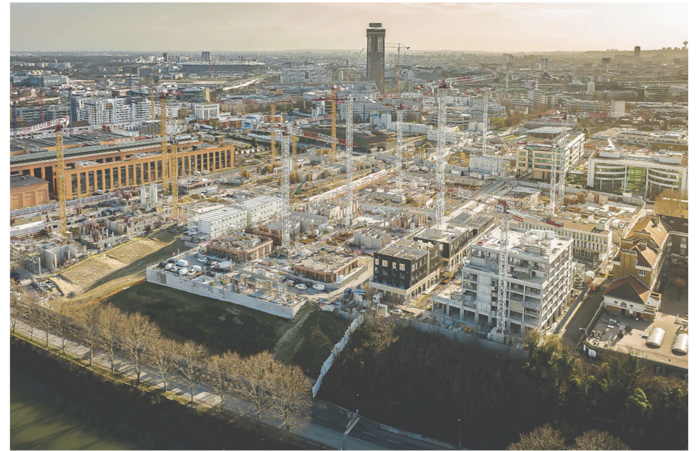
Le Village en chantier, juin 2022
