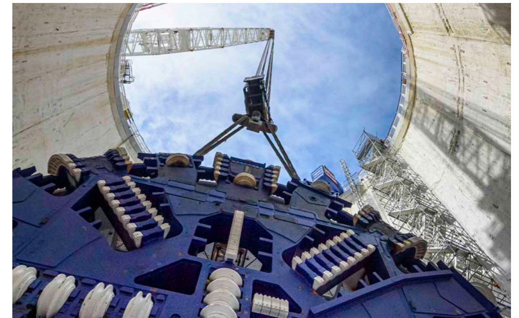
Descente de la roue de coupe du tunnelier Caroline à Massy © Gérard Rollando / SGP
